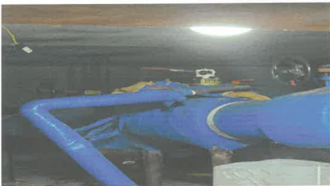
기계실 저수조 입수전동밸브 전자변 교체
