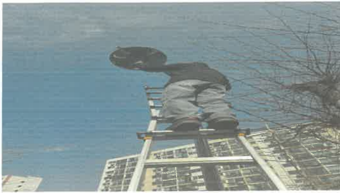
센터외곽 가로등 1개소 등 교체
