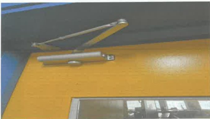
2층 유스5실 도어클로저 보수
